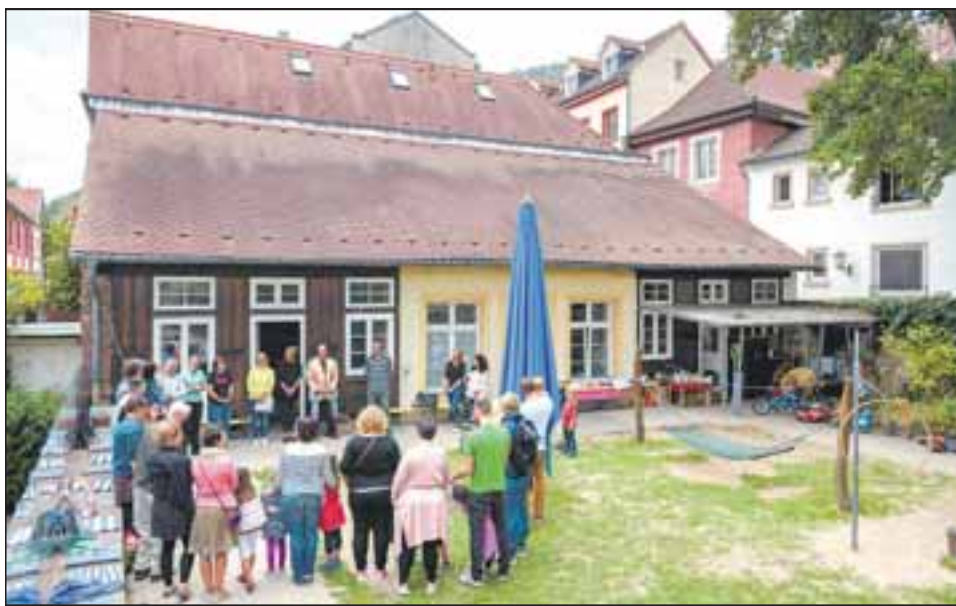
Als Kindergartenstandort bleibt die Remise des Schmitthennerhauses in der Heiliggeiststraße erhalten. Eltern, Kinder und Erzieher feierten die Übergabe der Trägerschaft. Foto: Rothe
